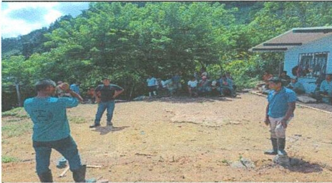
Foto1: Haciendo el terrepalen donde se va a realizar la construcción.
