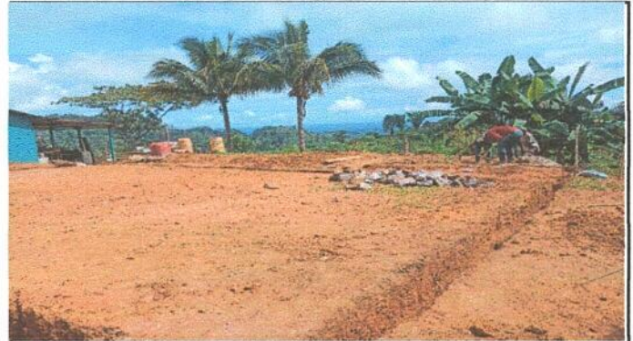
Foto 2: Zanjeo para las 2 aulas con un avance de 5%.
