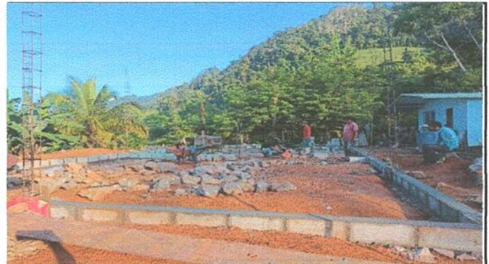
Foto 4: Primera hilada de bloc sobre la cimentación con un avance de 15 % .
